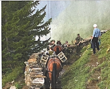
Abladen vor Ort: Auf dem Wanderweg neben dem bereits fertigen Mauerteilstück wird Kies angeliefert.
